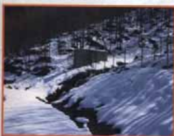
Un'immagine invernale del manufatto di raccolta delle sorgenti denominato Grotticelli, che si trova nei pressi dei Prati di San Geminiano a Piandelagotti
